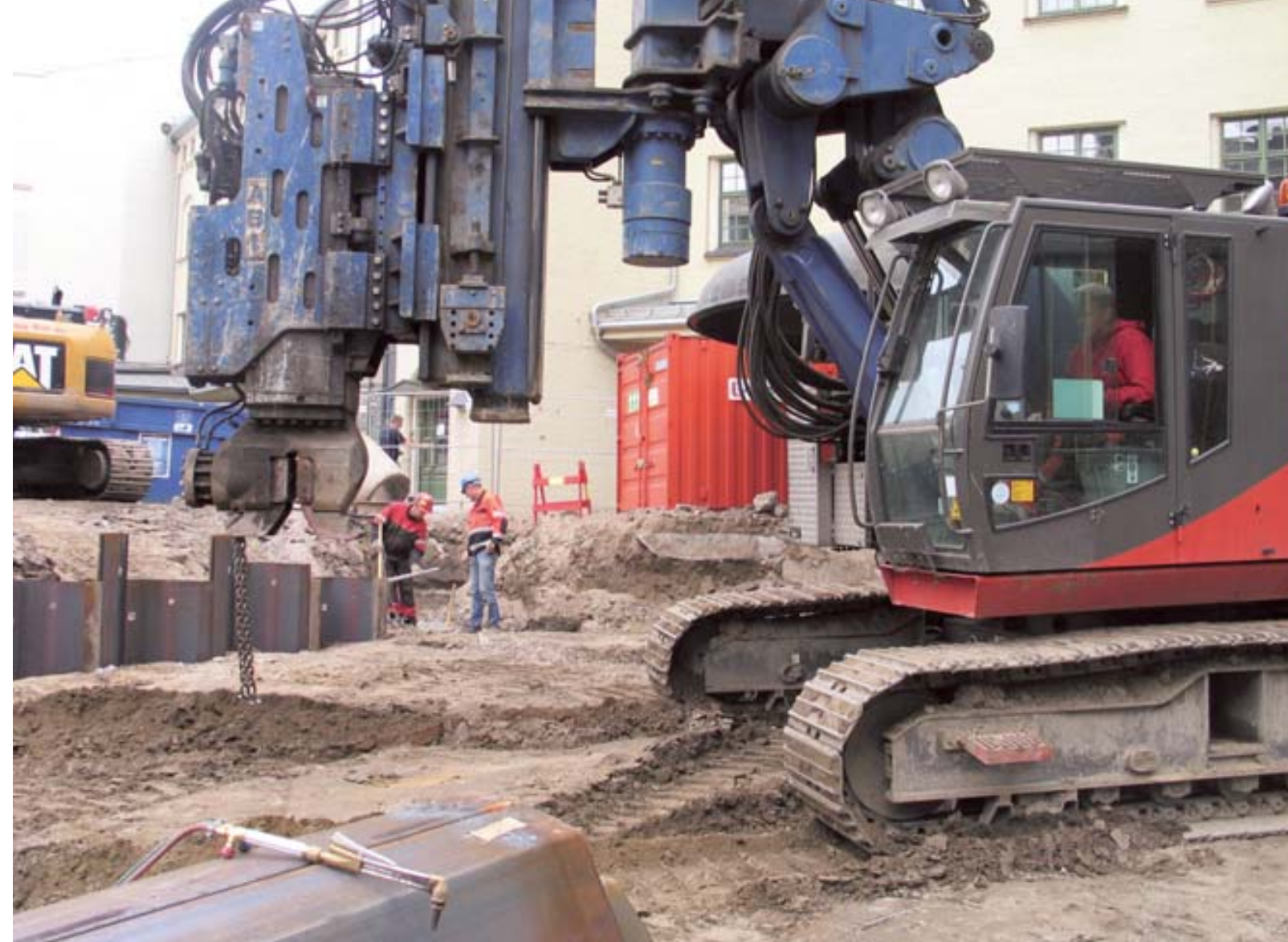
Arvid Eriksen og Alf Aurland sjekker spunt i det fjerne, mens Rune Alfsen i ABI-riggen er klar for neste spunt nål.
