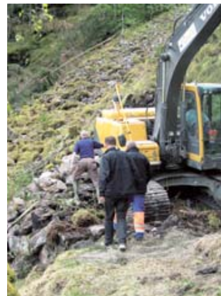
John Engesgaard (bakerst) på anleggsbefaring ved Rasdalen Kraftverk.
