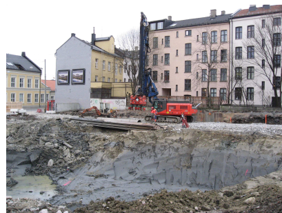
Maridalsveien 10, Oslo - Nærmeste nabo gamle bygårder fundamentert på tømmerflåte ...
