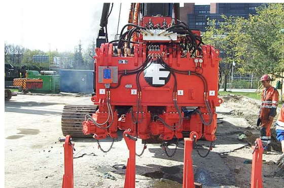
Enheten kan jobbe med fire spuntnåler i syklus
